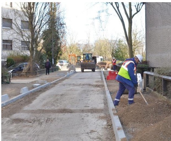
Travaux rue Lefebvre
