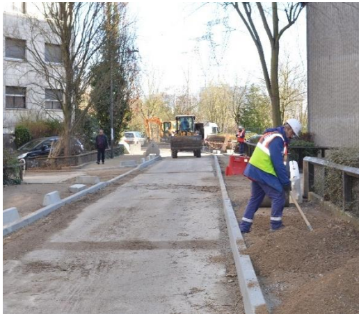
Travaux rue Lefebvre
